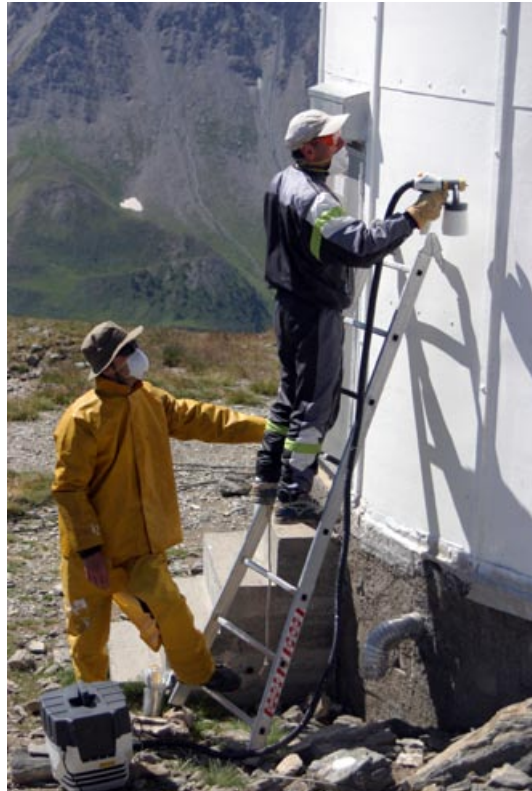
Chantier « peinture » de la grande coupole en 2011
