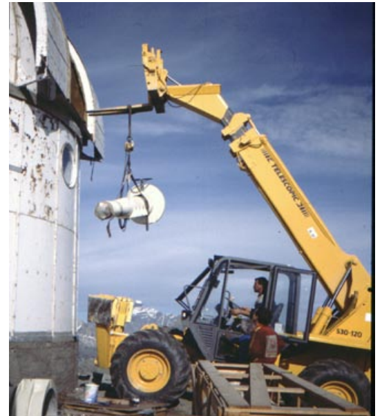
Installation du télescope de 62 cm prêté par l'OHP dans la coupole
