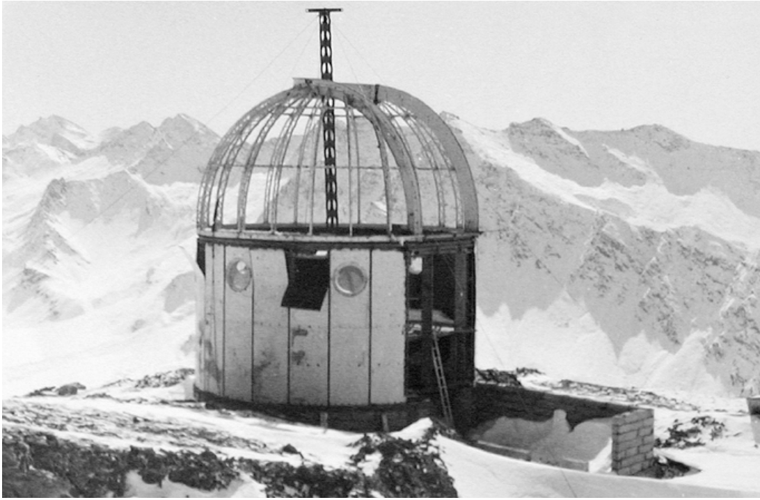
Coupole Eiffel en cours de remontage au Pic de Château-Renard
