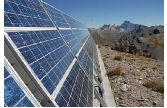
Panneaux solaires de la centrale photovoltaïque. Puissance : 7 kWc
